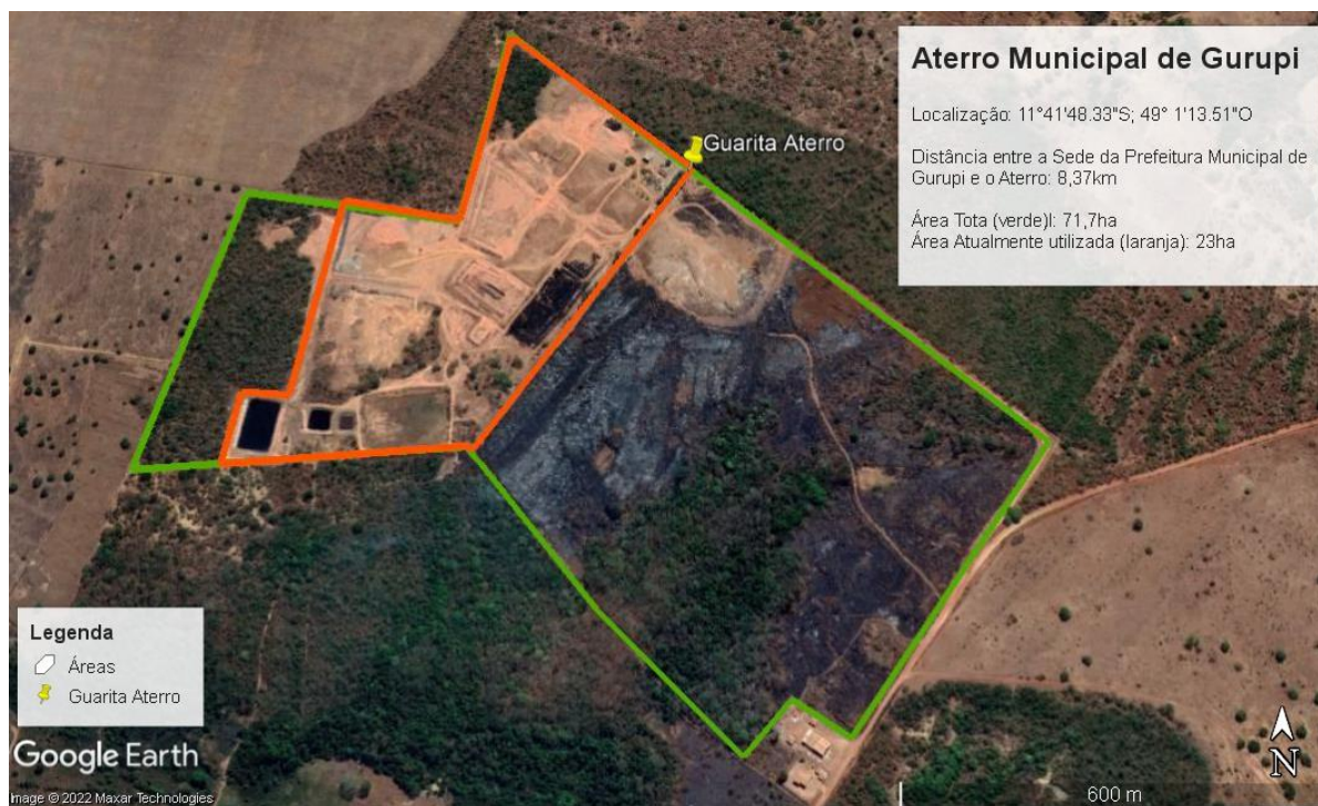
Figura.: Vista superior do Aterro Sanitário Municipal de Gurupi-TO.
